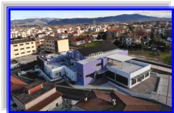
Εικ.43: Κτίριο Διοικητικής Μέριμνας
